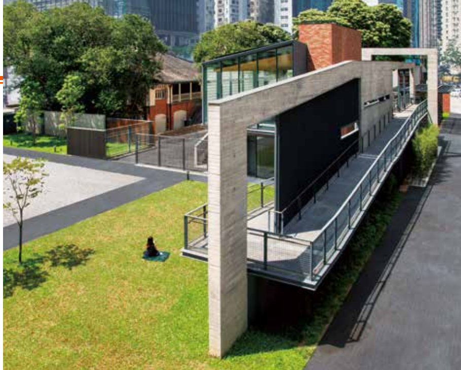
▲ 新館亦運用現代建築手法，包括以金屬斜屋頂和紅磚外牆等物料，呼應旁邊的歷史建築風格
